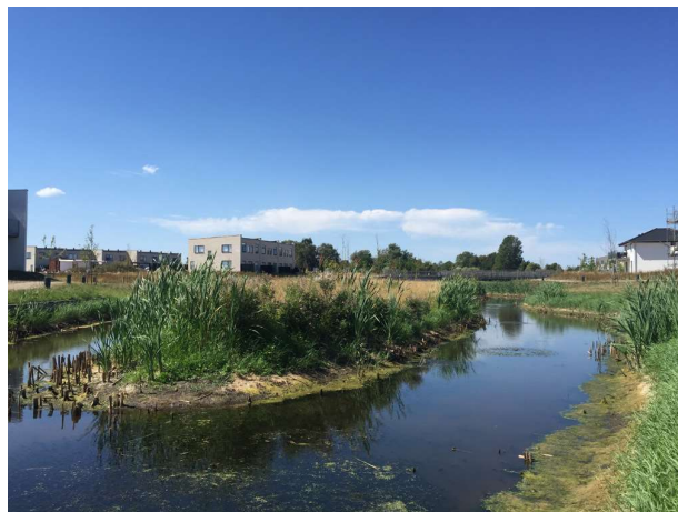
Figur 4: Bassin B303 i 'Deltaet', der renser og forsinker tag- og overfladevand fra det eksisterende kvarter.
